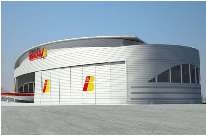
El hangar, de forma ovalada, tendrá un diseño arquitectónico singular y vanguardista para conseguir una mejor integración en el entorno urbano de El Prat. Cuenta con 12 puertas curvas que se controlan mediante pantallas táctiles situadas en los extremos, y permiten la visión de todo el frente del hangar durante la apertura o el cierre de las mismas, lo que tiene
